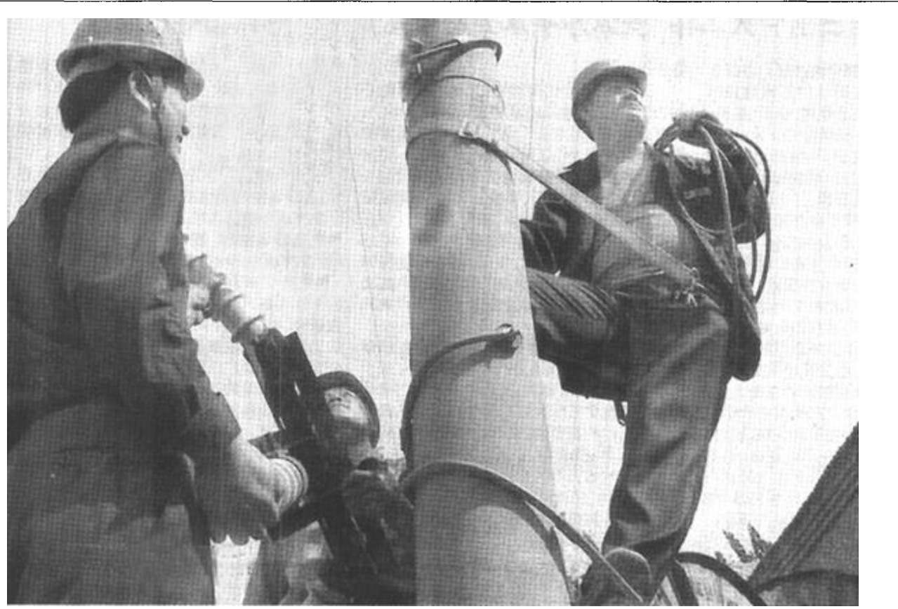
广饶县电力安装公司积极配合二期农网改造工程,进行电力设施安装工作。目前该公司已把二期工程的第一批工程全部安装完毕。图为电力安装职工正在进行电力安装作业。(高祥 孙学良 摄)
